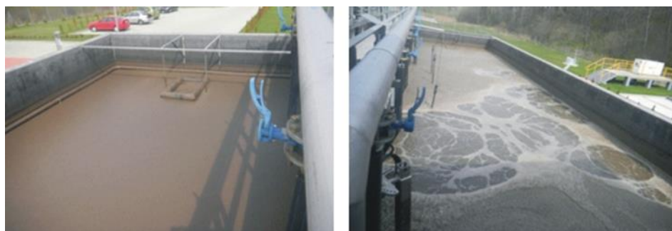
Osad spęczniały i piana na powierzchni reaktorów - bez dawkowania keramzytu (po lewej) i z dodatkiem keramzytu (po prawej).
